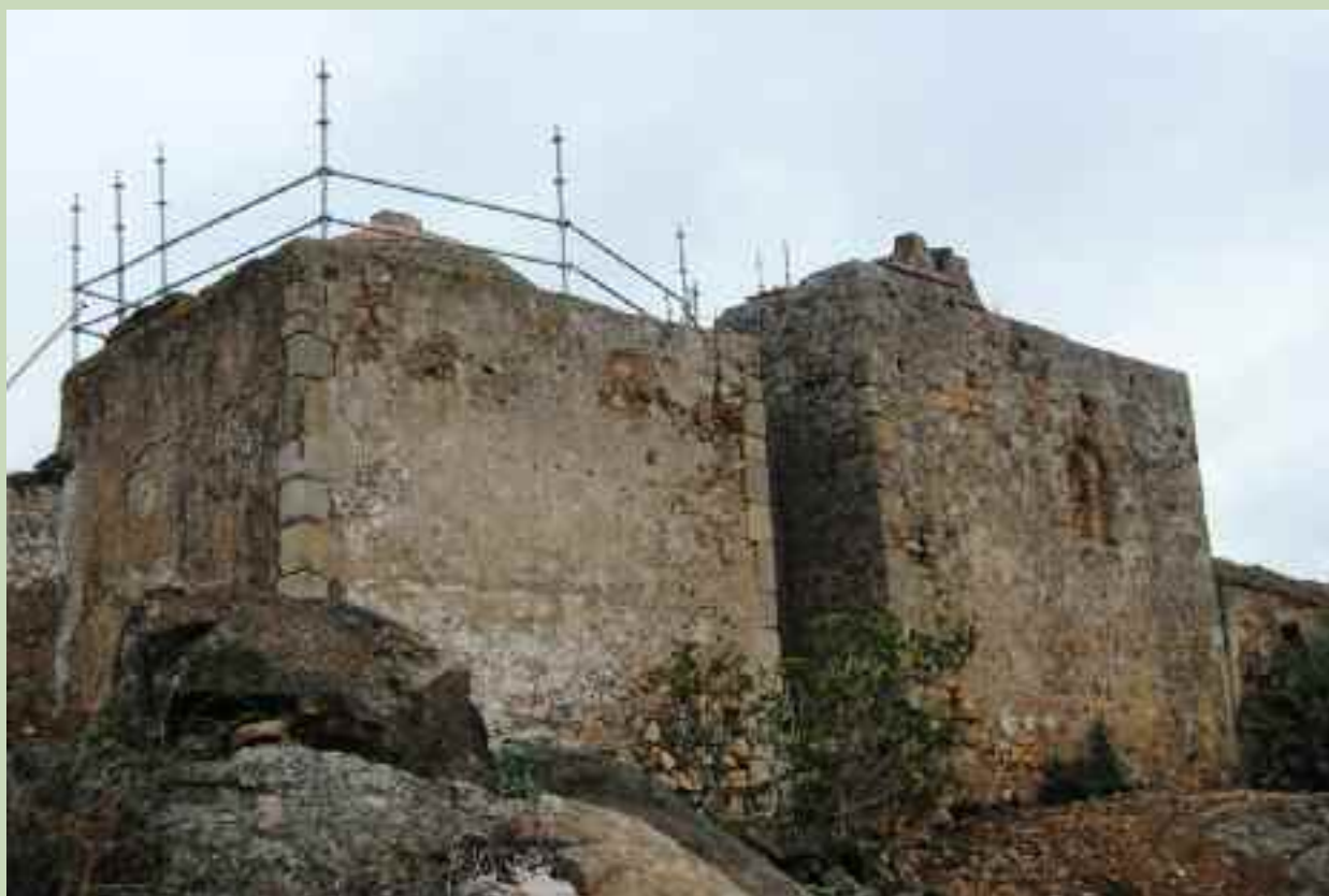
Fig. I Fachada sur exterior de San Juan. Detalle columna reutilizada.
